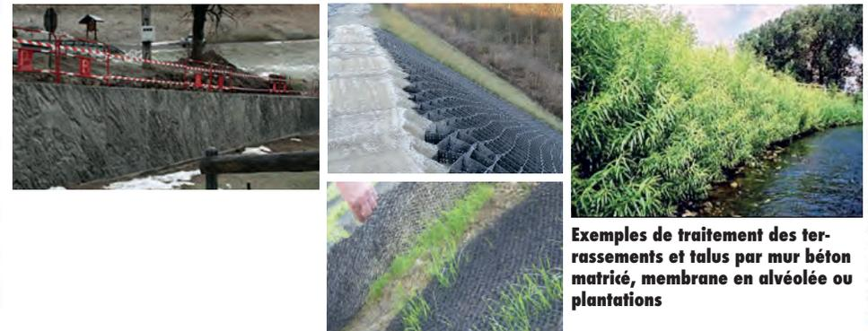
Exemples de traitement des terrassements et talus par mur béton matricé, membrane en alvéole ou plantations
